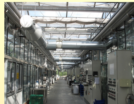
Einrichtung für die geregelte Luftzufuhr zu den Gewächshäusern
