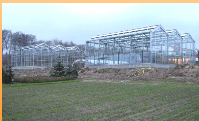
Abb. 4: Stand der Bauarbeiten im November 2010
